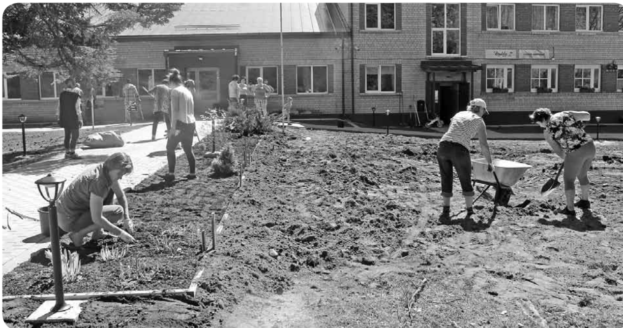
Kultūras nama teritorijā galvenie sakopšanas darbi bija zemes līdzināšana un apstādījumu veidošana.
