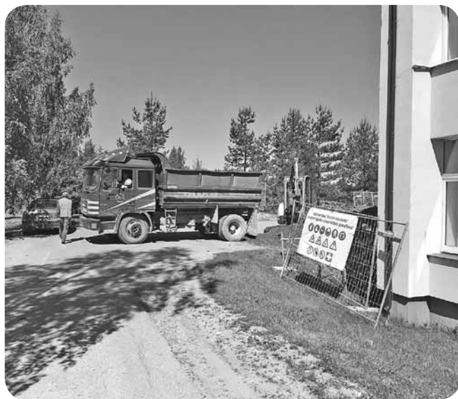
Pie Ļaudonas pensionāta rosiņa. Uzsākti lifta izbūves būvdarbi.
